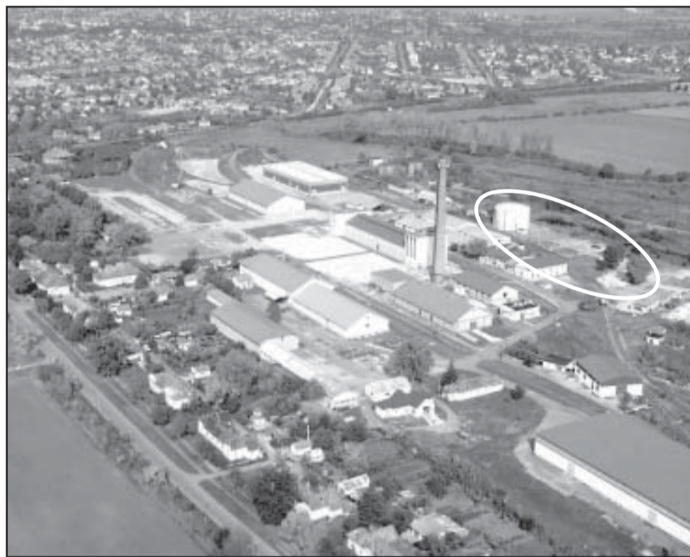
A Sarkadi Ipari Park madártávlatból. Az új üzem jelenleg a fehér vonallal körülhatárolt területen épül
