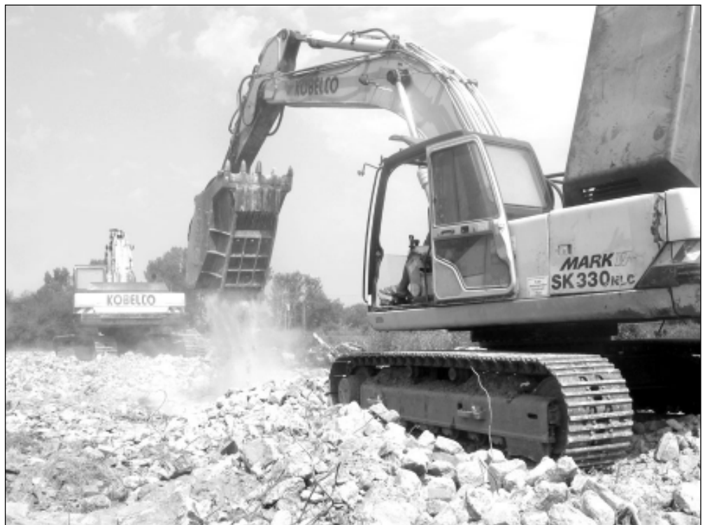
A kőtörő gép munka közben az Anti úton
